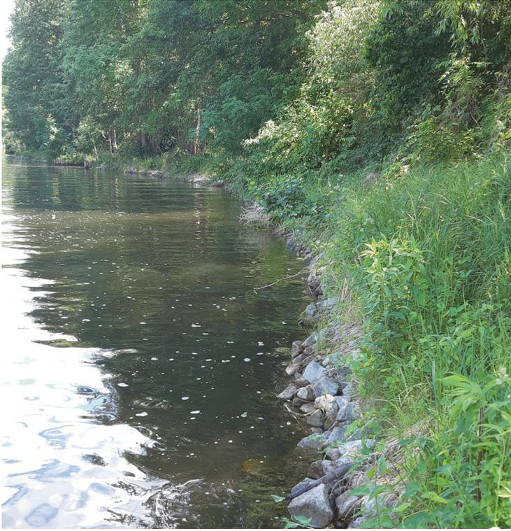
**Abb. 3: Obere Havel, Ufebefestigungen mit Steinschüttungen**
